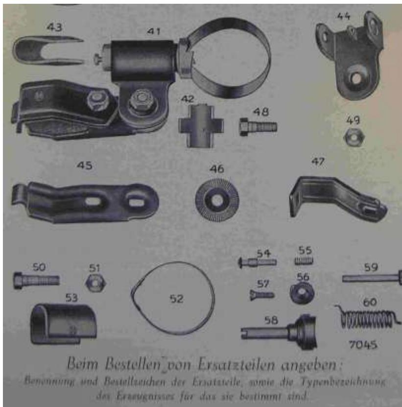
Bild 5.29: Bestellliste für die Einzelteile der Kippeinrichtung
